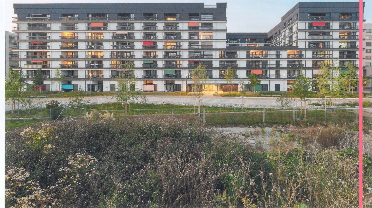
Abb. 11 Wohnen ‚Am Rietpark‘ Dank farbigen Sonnenstoren erhält jede Wohnung einen individuellen Touch.
